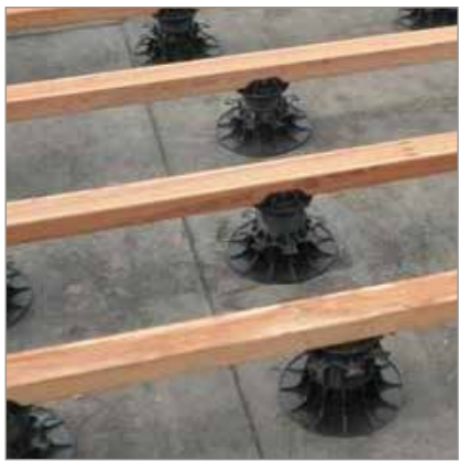
Dimension der Unterkonstruktionshölzer: 68 x 40 mm
