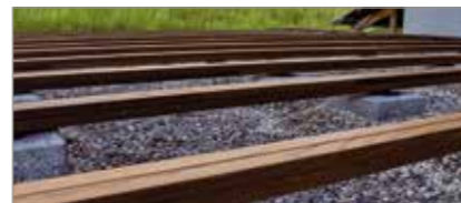
Unterkonstruktion nicht direkt auf den Untergrund setzen.
