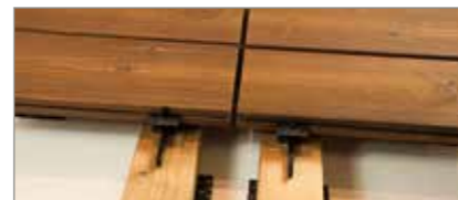
Die Längsstöße müssen auf zwei Unterkonstruktionshölzer liegen.
