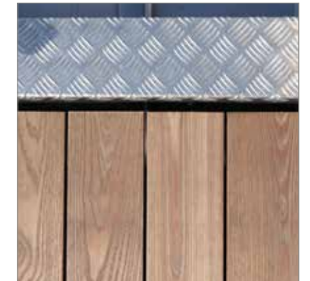
Mindestabstand zu anderen Bauteilen von 20 mm.
