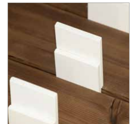
Distanzhalter für eine regelmässige minimale Fugenbreite von 7-8 mm.
