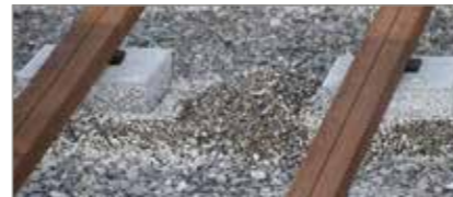
Max. Abstand zwischen den Unterkonstruktionshölzer 500 mm.
