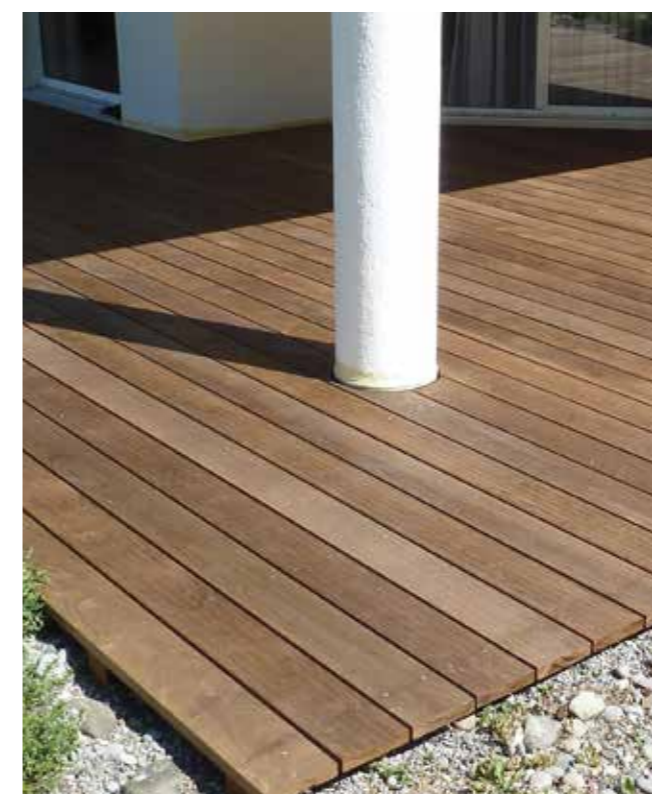
Frisch verlegte Terrasse
