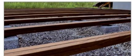
Unterkonstruktion nicht direkt auf den Untergrund setzen.
