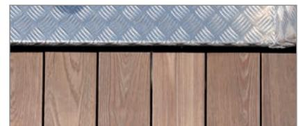
Gute Unterlüftung wird gewährleistet bei einem Mindestabstand zu anderen Bauteilen von 20 mm.
