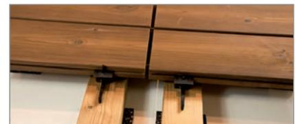
Die Längsstösse müssen auf zwei Unterkonstruktionshölzer liegen.
